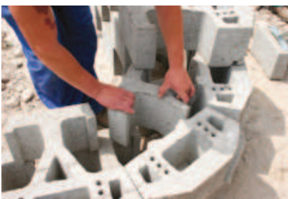
kotvení v druhé vrstvě
