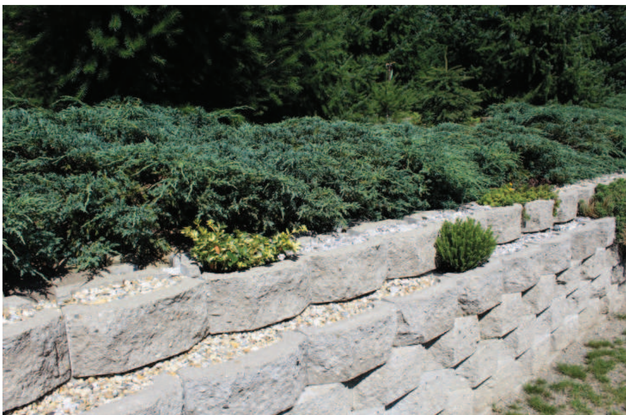
Svah vytvořený vložením prvků FLAT nebo BENT mezi prvky POT – sklon svahu cca 53^\circ až 60^\circ
