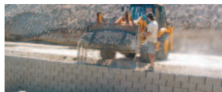
Štěrkový zásyp před položením dalších vrstev
