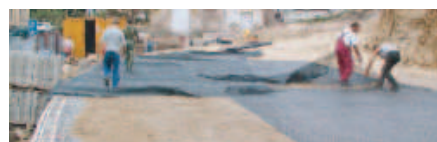
Rozprostření zemní rohože
