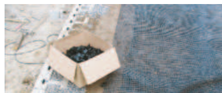
Čelní zeď před položením zemní rohože
