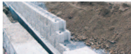
Příprava čela na položení dalších vrstev
