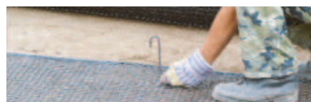
Uchycení rohože v pláni skobou
