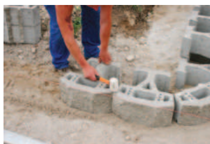
první vrstva – vyrovnání do roviny pomocí gumové paličky
